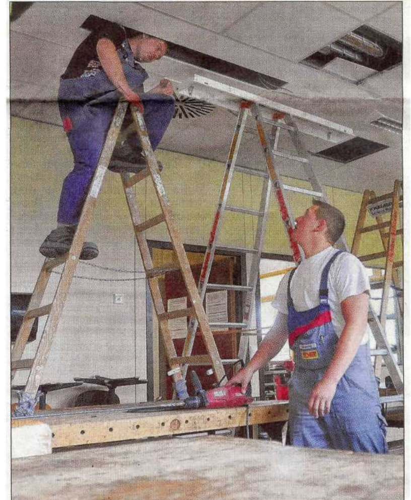
Am Montag ist die Decke zu: letzte Arbeiten auf dem Höhnisch. Bild: Rippmann
